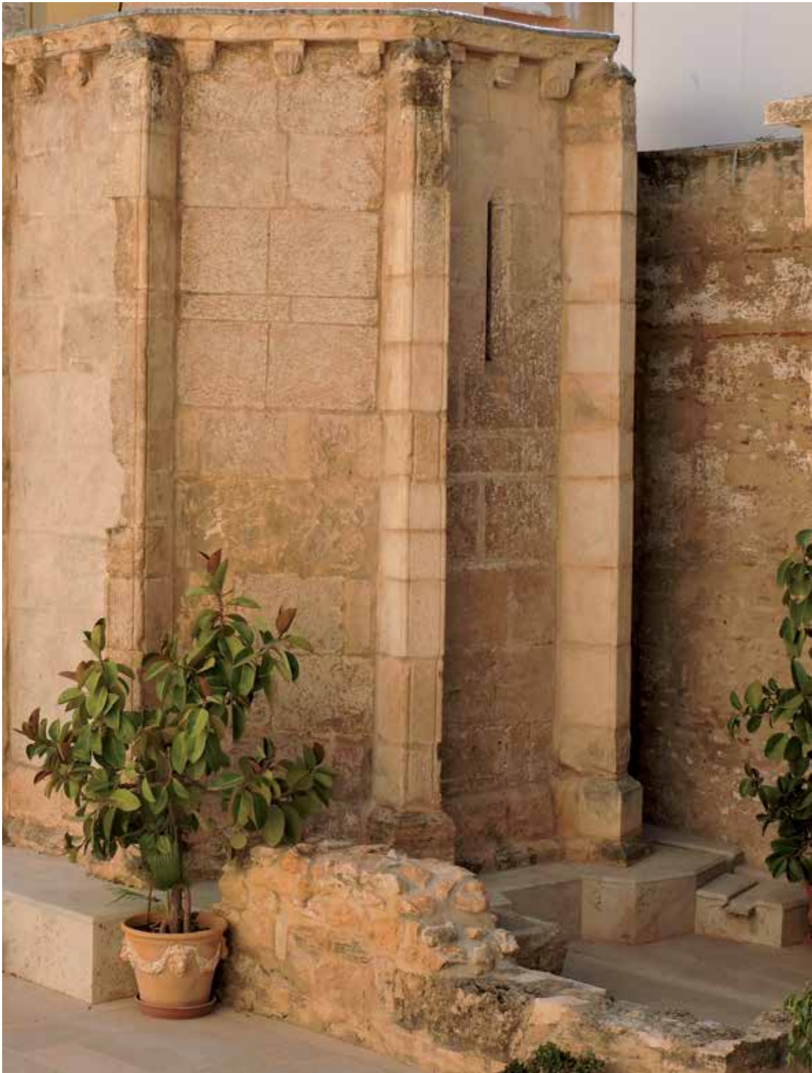
Fig. 5.- Cabecera poligonal de la Capilla de Arnau de Romaní provista de canecillos.
